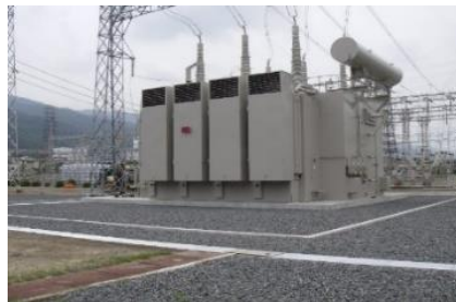
(機器基礎工事)
