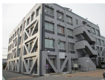
(一般建物の建築工事)
