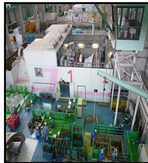
(火力発電所の保守工事)
