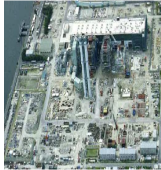
(火力発電所の建設工事、除却工事)
