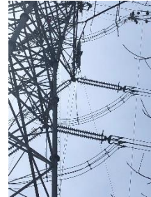
(架空送電線電線張替工事、碍子取替工事)
