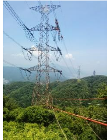
(架空送電線電線張替工事、碍子取替工事)
