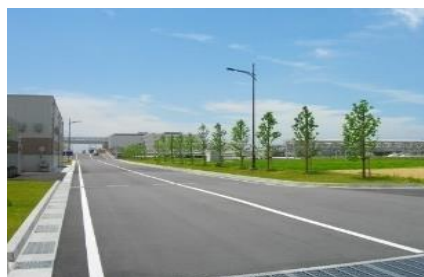
(緑地改修・新設工事)
